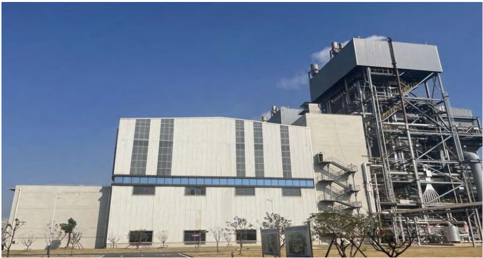
图 15-3 武汉钢铁亚临界煤气发电机组
