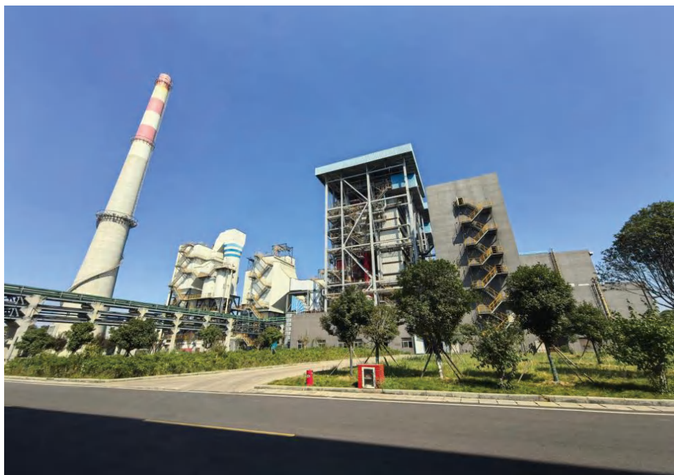
图 15-13 热电联产综合利用项目
