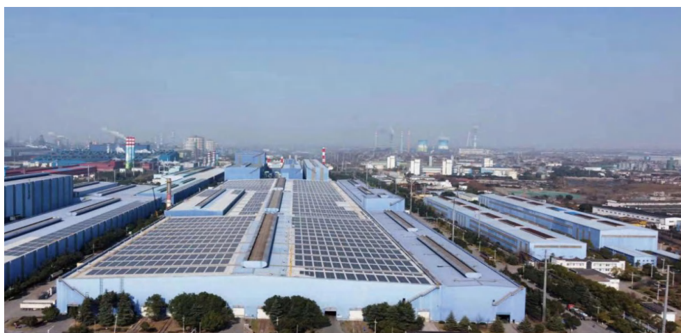
图 15-4 厂区屋顶分布式光伏项目
