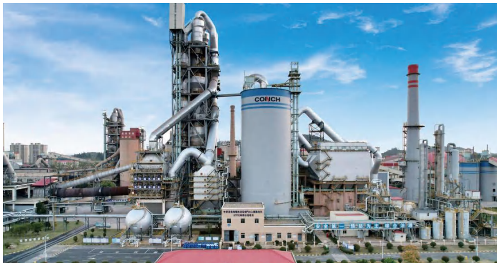
图 15-7 白马山水泥厂二氧化碳捕集纯化项目
