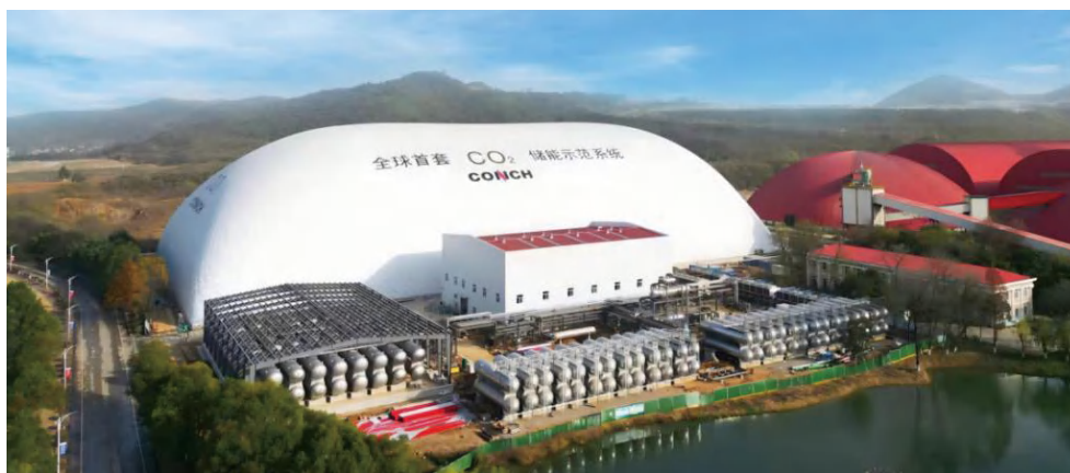
图 15-8 10 兆瓦 /80 兆瓦时二氧化碳储能示范系统
